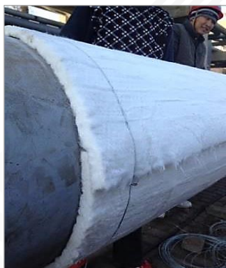
管道气凝胶保温施工
