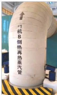
主蒸汽管道气凝胶保温施工
