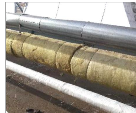
导热油管道气凝胶保温升级改造替代岩棉保温
