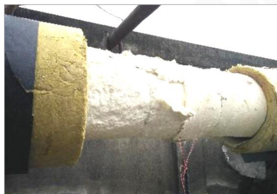
气凝胶替换岩棉保温材料施工
