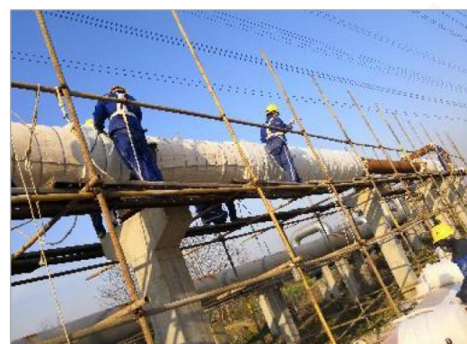
气凝胶复合硅酸镁保温施工
