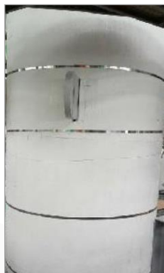
主蒸汽管道气凝胶保温施工
