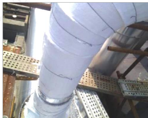
高温蒸汽弯头气凝胶保温材料施工
