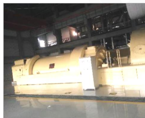
汽轮机设备气凝胶保温
