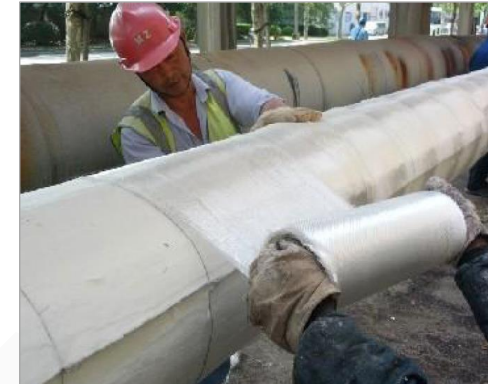
120度热网气凝胶保温材料施工
