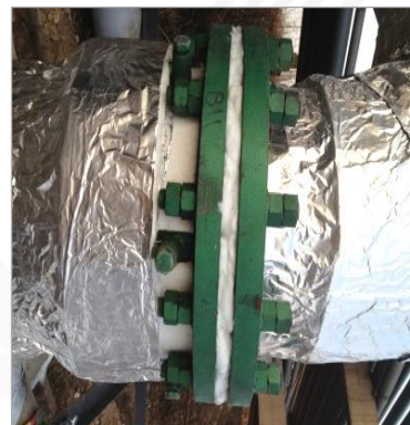
管道与法兰保温保温施工
