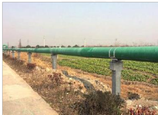
300度热网管气凝胶保温材料施工
