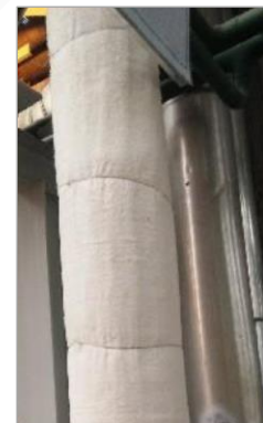
汽轮机进气管道气凝胶保温施工
