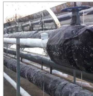
导热油管道气凝胶保温升级改造替代岩棉保温
