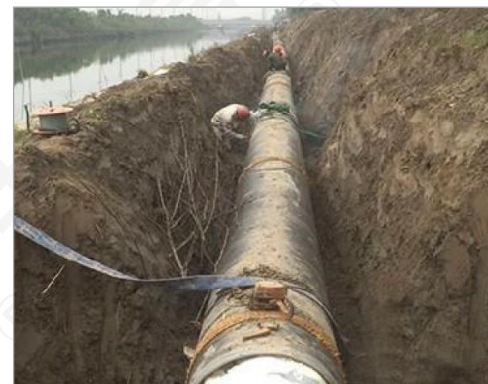
埋地管道气凝胶保温材料施工
