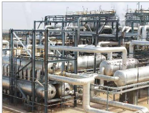
熔岩塔式发电设备及管道保温
