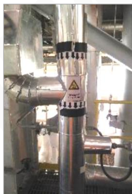
汽轮机进气管道气凝胶保温施工
