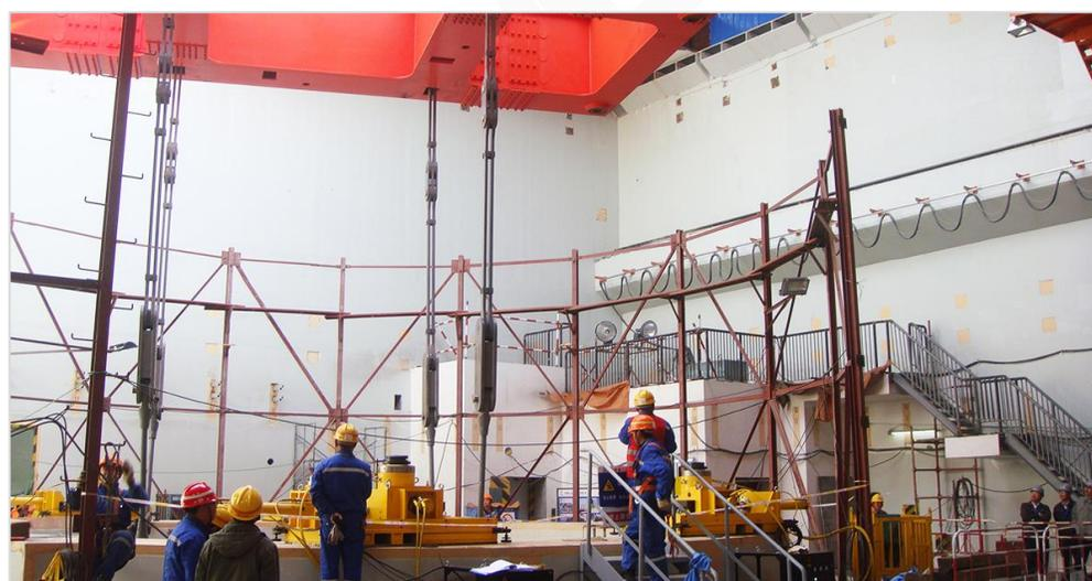
CIT-MCAD系列智能型伺服控制高精度核反应堆钢质外壳与蒸汽发生器三维调整与定位设备应用图片（浙江三门AP1000）
