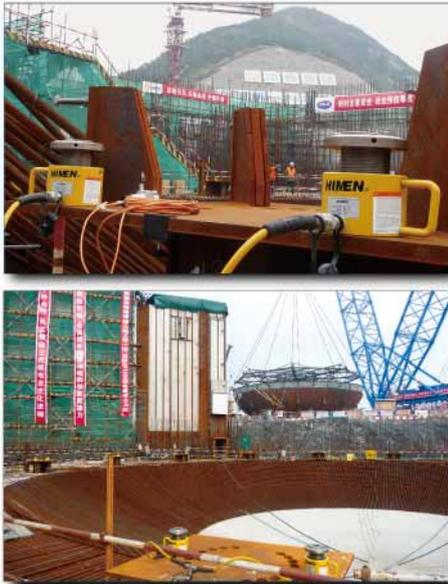
低碳经济时代，核能发电作为一种大规模可持续的能源之一，越来越受到重视，特别是第三代核电技术的发展，使得核能发电的重要性日益提高。三门核电站，作为全球第一个采用AP1000核电技术的核电站，核岛反应堆壳体采用了模块化制作和安装方式。
