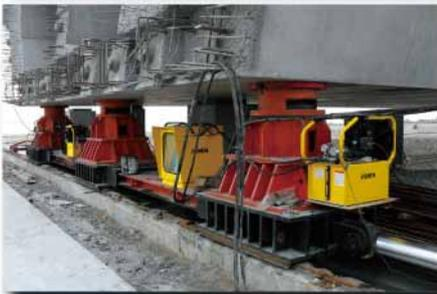
广深沿江高速公路是广东省“十一五”规划重点建设项目，也是国家公路干线网的组成部分，在深圳宝安机场地域的跨海段部分采用了跨径为60m的单箱双室截面巨型混凝土箱梁，该箱梁长60米，高3.5米，顶板宽19.65米，底板宽10.35米，该箱梁平均梁重达2400吨，在同类型桥梁中居世界之首，有着“世界梁王”的称号。
