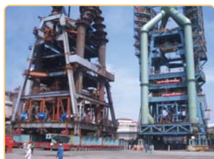
1号高炉同步置换现场
