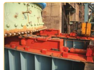
新高炉同步顶推滑移就位
