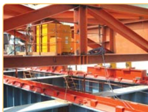
同步泵站、油缸及重载滑移轨道
