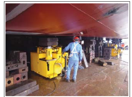
▲ RCA系列单台200吨自动型三维调整机在广州文冲船厂的船台上使用
