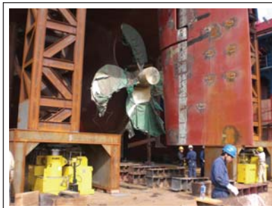
▲ 中船澄西修造有限公司浮坞内巨型总段造船法工艺工程实例（2000吨重巨型总段）
