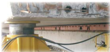
▲ 2400吨重载移梁台车应用在杭州湾跨海大桥70米箱梁移运工程
