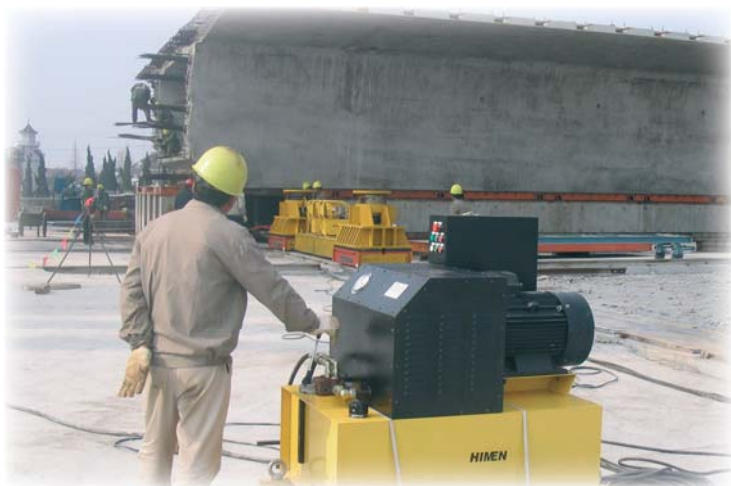
▲ 2400吨重载移梁台车应用在杭州湾跨海大桥70米箱梁移运工程
