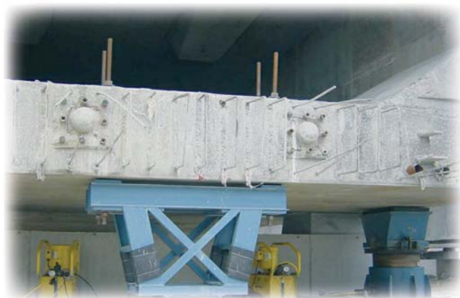
▲ 型号为EPM2420W的防腐电动液压泵站配合HSL系列单作用机械锁紧油缸用于海上混凝土梁的调整
