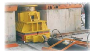
▲ 2400吨重载移梁台车应用在杭州湾跨海大桥70米箱梁移运工程
