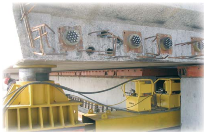
▲ 型号为EPM4460W的电动液压泵站配合800吨HSL系列单作用机械锁紧油缸用于2400吨混凝土梁的顶升
