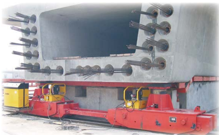
▲ 客运专线900吨移梁台车在石太线工程中应用
