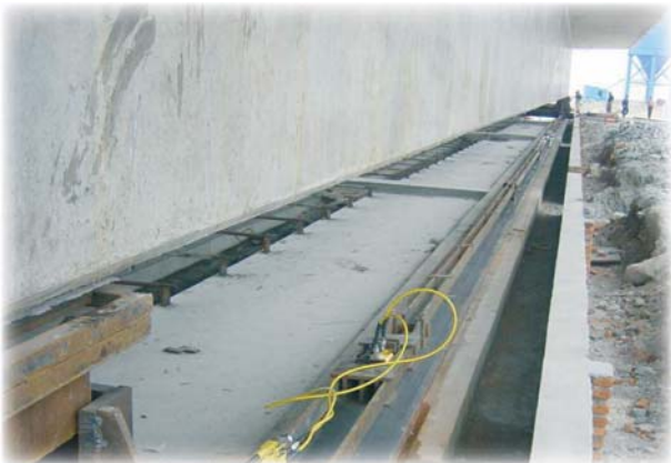
▲ HD10010双作用液压缸和P44手动泵组成的液压系统应用于70米梁移梁台车连接钢带的预紧
