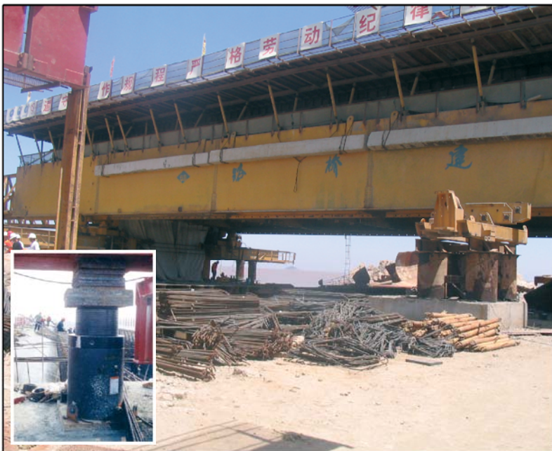
颍珠山大桥40米跨径移动模架采用HIMEN的整体液压系统和设备
