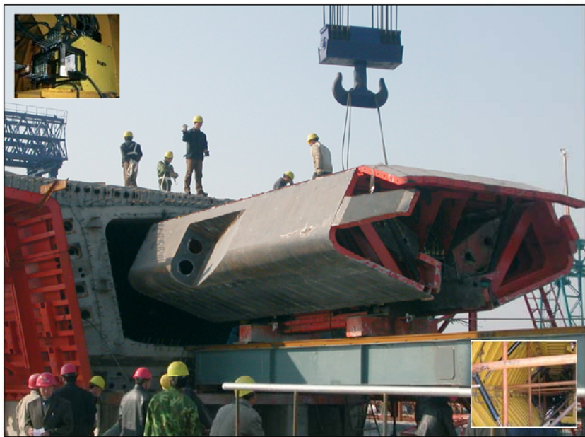
杭州湾跨海大桥70米梁采用HIMEN的全液压同步控制系统方案和设备
