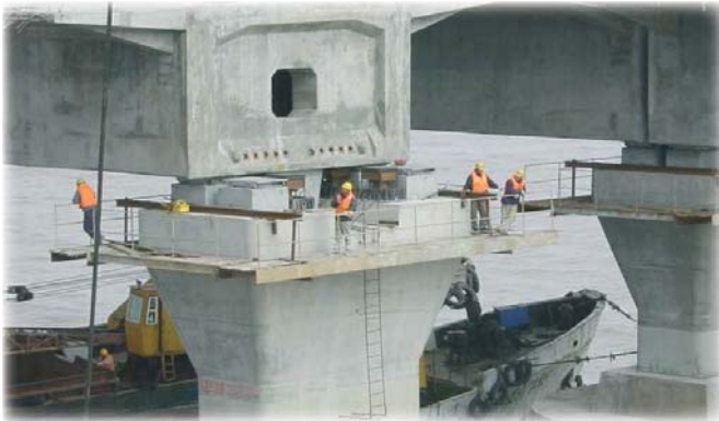
▲ MCA/3/4-2400型应用于跨海大桥箱梁的空间位置精确调整
