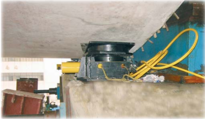
▲ MCA/3/4-1400型应用于1200吨高架箱梁的空间位置精确调整
