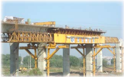
▲ MCSS40型应用于下行式移动模架
