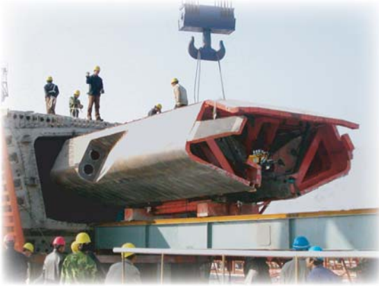
▲ MCS70型液压系统在杭州湾大桥70米梁的应用
