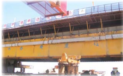
▲ MCSS50型应用于下行式移动模架
